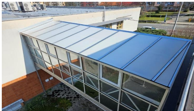
Nová střeška průchodu mezi 1. a 2. budovou MěÚ
