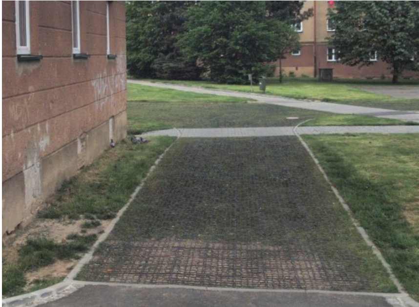
Obrázek 17 Příklad řešení parkování plastovými zatravnovacími rohožemi
