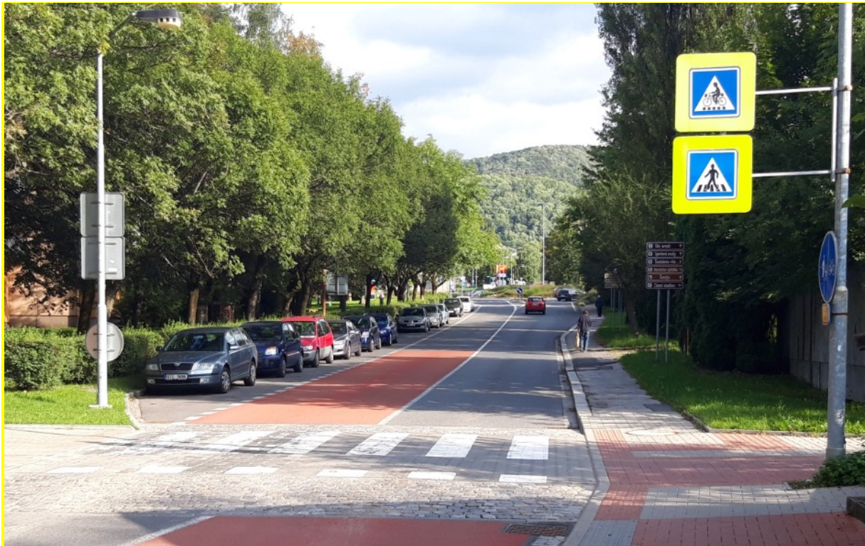
Obrázek 26 Vhodná úprava cyklopřejezdu a přechodu pro chodce na zvýšeném prahu s dopravním značením na výložnicích, příklad z jiného města Kopřivnice, ulice Husova
